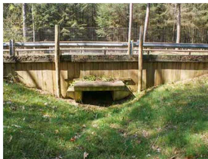
Kleine tunnel onder provinciale weg.
