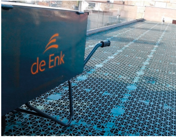
Daktuin voor een Amsterdams hotel met waterretentie en een vertraagde afwatering.
