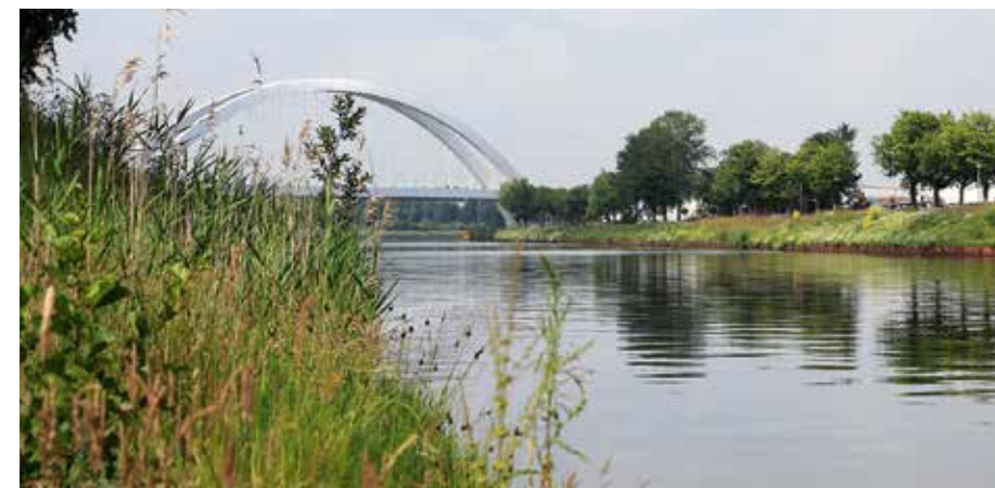
Het Van Starckenborghkanaal, onderdeel van de Hoofdvaarweg Lemmer-Delfzijl. De hoofdvaarweg is een van de projecten waar Bertus een bijdrage aan levert.
